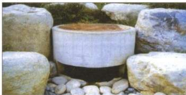
Fot. 1 Betonowa studnia chłonna
